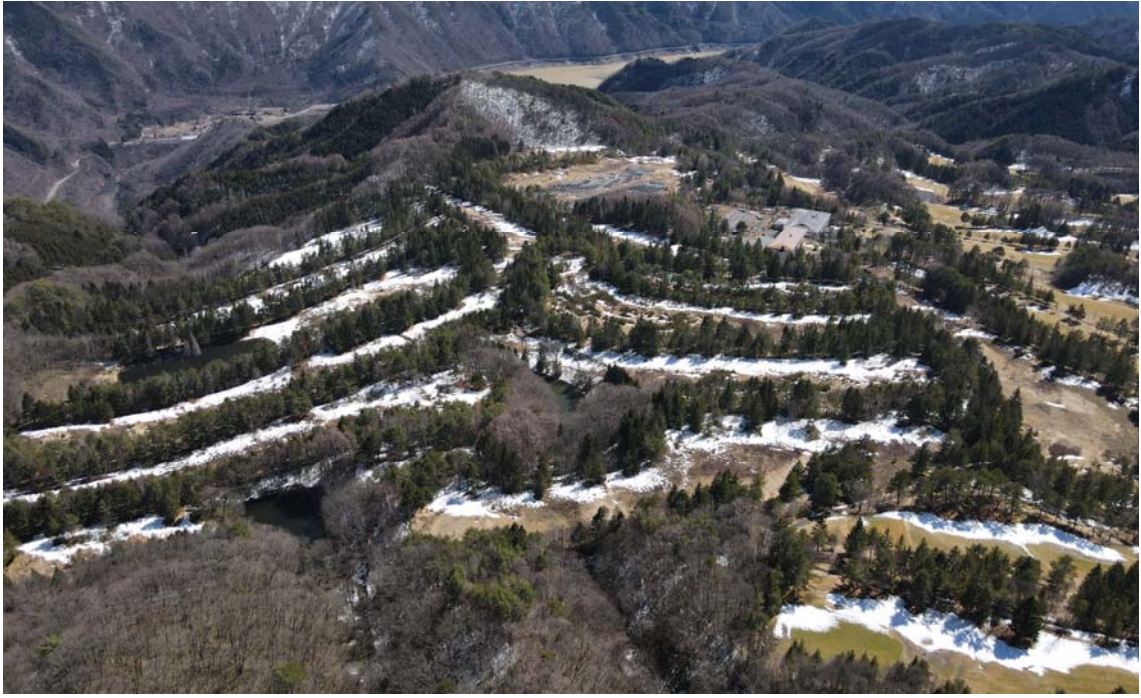
木曾三岳太陽光発電所 建設予定地
